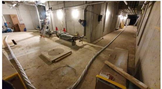
Installazione centrifuga mobile per avanzare con i lavori del canale d'entrata
